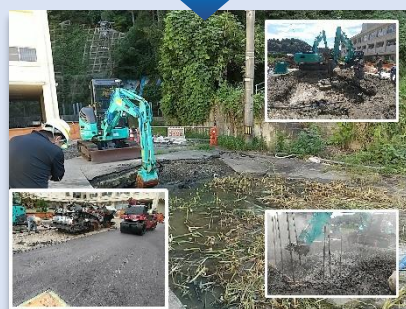
浄化槽の撤去、解体復旧工事
