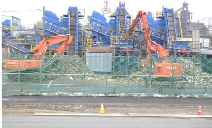
岡山県での作業現場の様子
