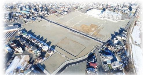
▲山梨のブラウンフィールド再生流動化事業の現場
