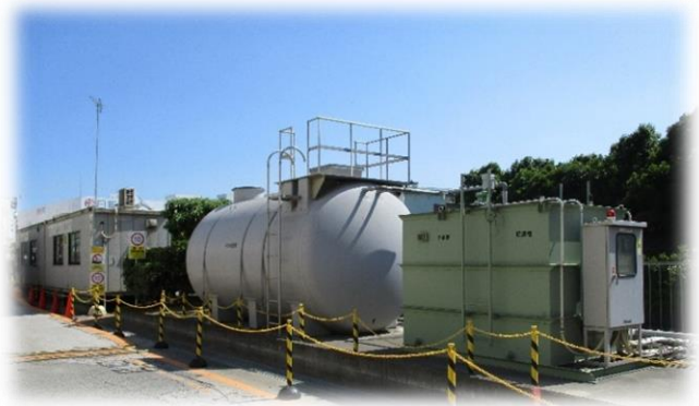
▲雨水中和装置（横浜RC）
