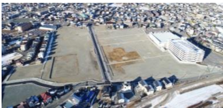
▲プロジェクト現場 (敷地面積：約50,000m 2 、対策範囲：約23,800m 2 )
