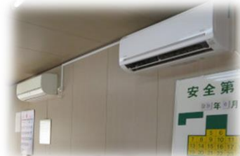
▲エアコンの追加設置
