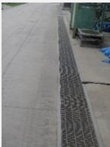
▲側溝による流出防止(名古屋RC)
