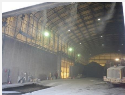
▲テント建屋入口におけるミストカーテン(横浜RC)
