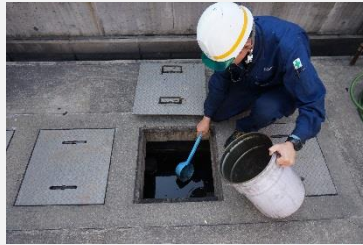
▲油水分離槽の清掃
