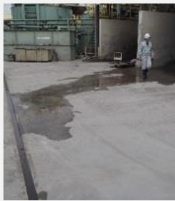
▲側溝による流出防止(名古屋RC)
