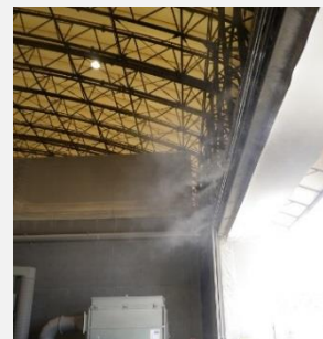
▲テント建屋入口におけるミストカーテン(横浜RC)
