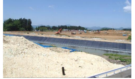
市内の埋立処分場(管理型最終処分場) 震災前後で埋立量が年間13万m 3 から25万m 3 に倍増し、2013年5月現在約81%までが埋まっています。
