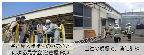
当社の解現場の廃家屋を救助訓練の場として消防署に提供いたしました。
