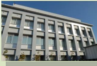
本社・環境技術センター
