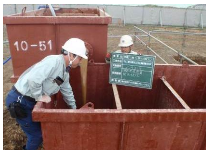
揚水した地下水の回収
