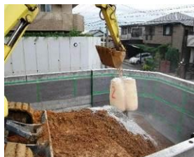
GA-2の施工風景
