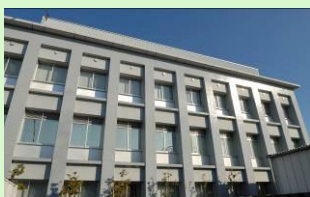
本社・環境技術センター
