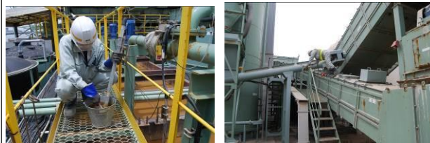
設備のメンテナンスの様子
