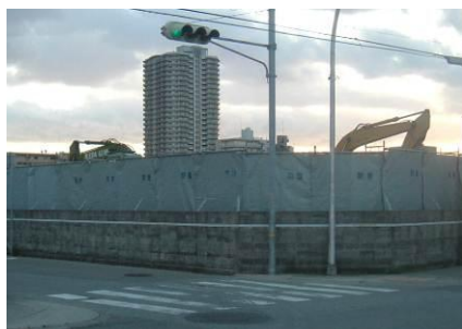
騒音対策(防音シート)
