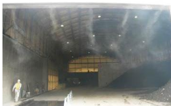
ミストによる防じんカーテン (横浜リサイクルセンター)
