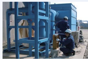
集塵機の排ガス測定状況
