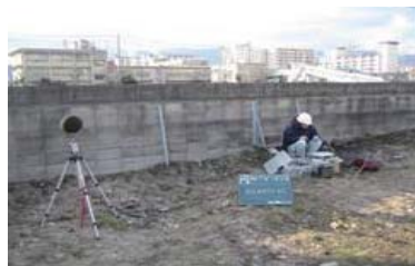
工事現場における騒音測定
