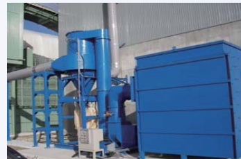
VOC専用集塵機 (右側の箱が活性炭ボックス)
