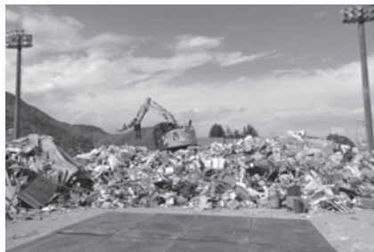
仮置場での分類作業
