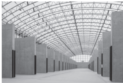
浄化土保管ヤード
