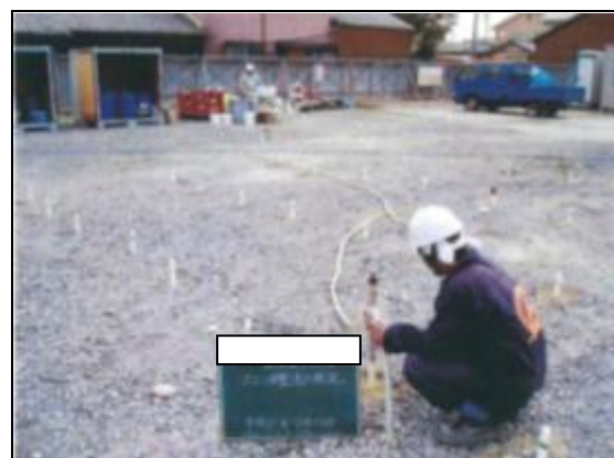
原位置浄化工事
