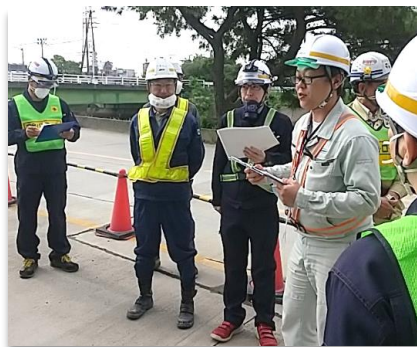
合同パトロールの様子
